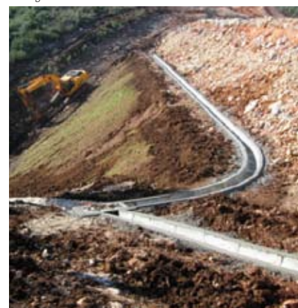
Drenagem de taludes
